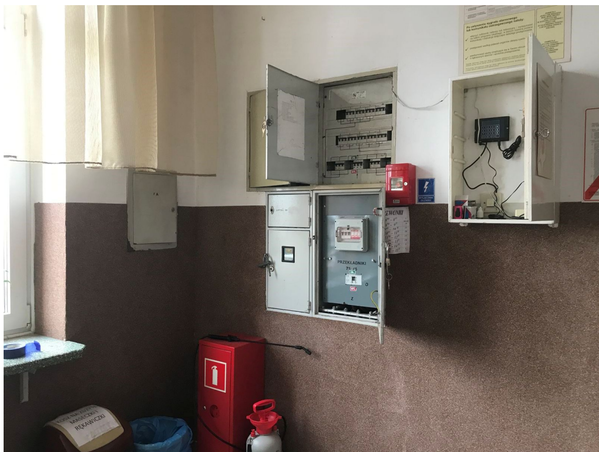
Zdj.2 Istniejące tablice TG1, TG2 wewnątrz budynku
